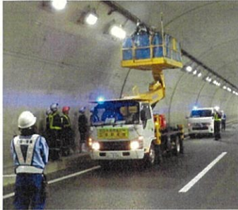
(トンネル灯具交換作業)
