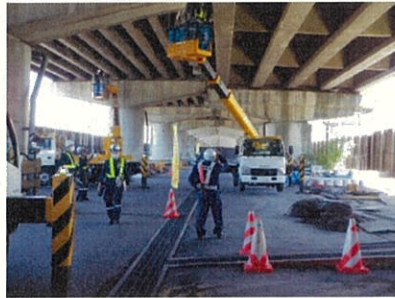
(橋梁詳細点検)
