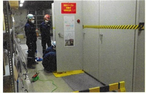
(電気設備定期点検)
