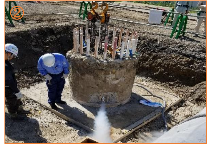
液体窒素注入状況。約10分で凍結管内の水が凍結し体積が膨張する現象を利用し杭にひび割れを発生させます。
