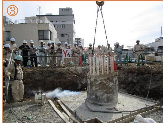
液体窒素注入状況。約10分で凍結管内の水が凍結し体積が膨張する現象を利用し杭にひび割れを発生させます。
