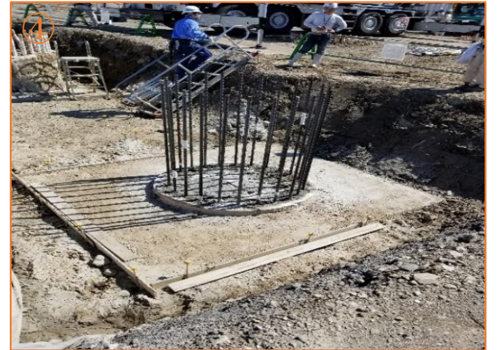
杭頭撤去状況です。杭頭内を小研りし仕上げます。当作業所の場合、NCベースがあるので部分的にレベル調整を行います。
