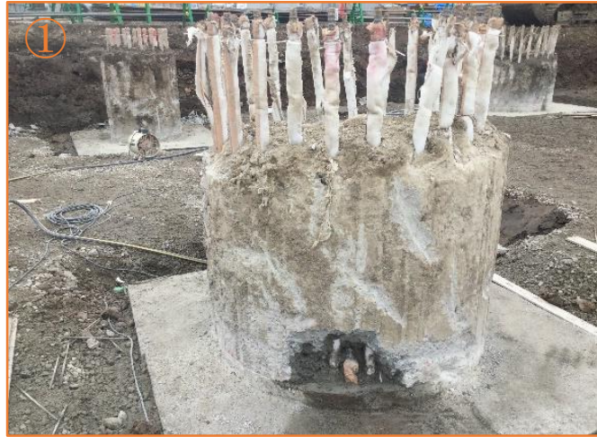
液体窒素注入・出口の研出し 所定高さで処理するためカッターも入っています。
