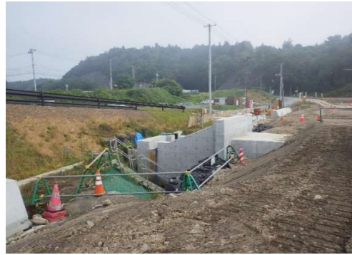
① 樋管本体内川裏側開口部
