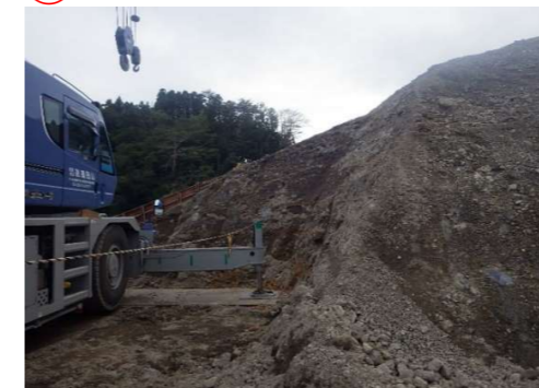
⑤ 隔壁工取付部の掘削法面
