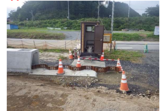
⑦ 法留コンと鋼矢板露出部
