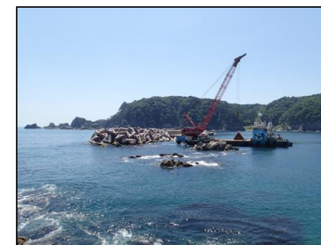
田老漁港災害復旧工事
