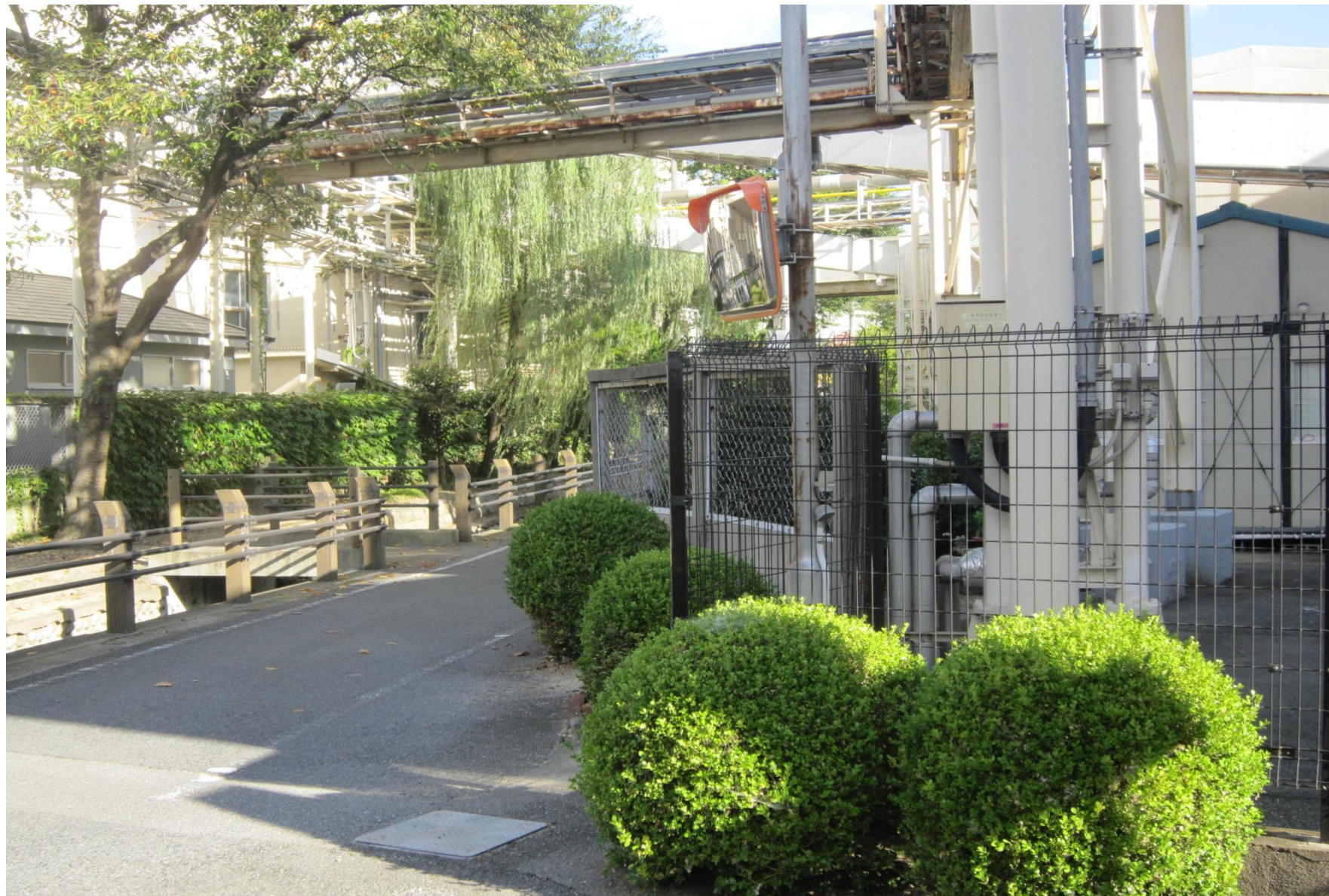
フェンス塀にして見通しの改善
