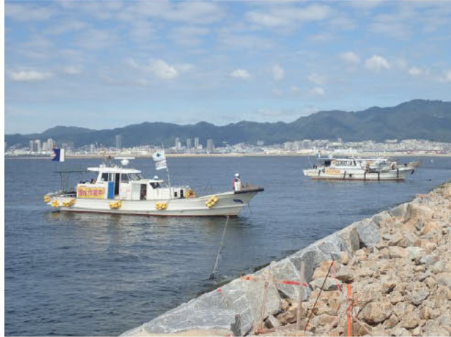
潜水士による潜水作業状況
