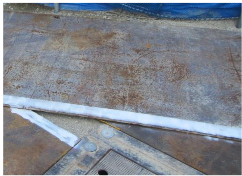
⑤鉄板段差明示
