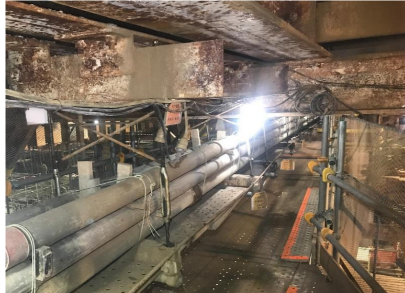
②通路部段差明示
