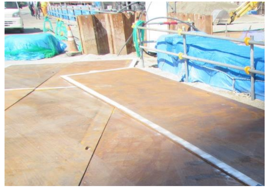
⑥鉄板段差明示
