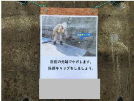
危険予知看板『差筋の確認』
