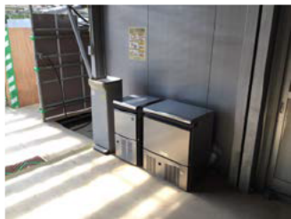
製氷機・冷水器設置
