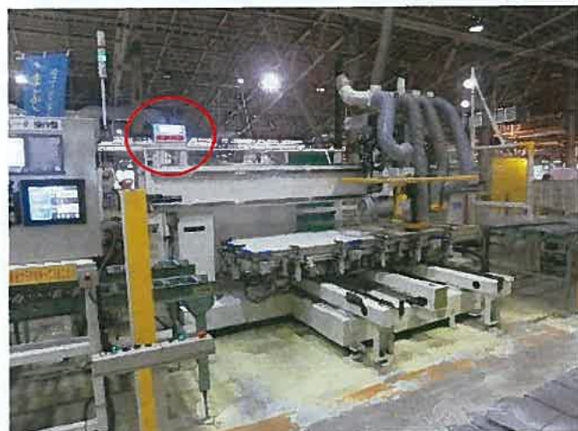
回転中の表示の場合は設備の稼働範囲には立ち入りを禁止
