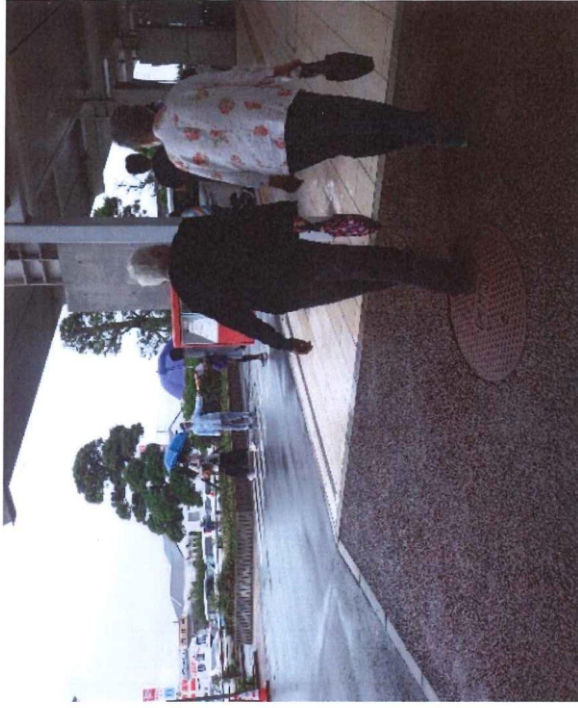
スロープ上の鉄蓋に滑り止め加工
