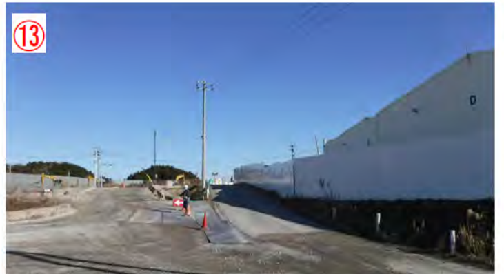
毛萱第1 仮置場 出入口付近
