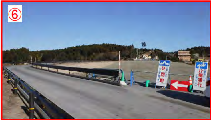
⑥ 工事中。迂回路 片側交互通行。 越えた場所が子安橋
