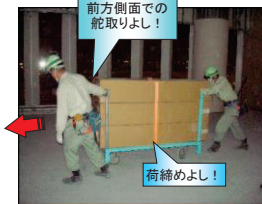
良い例 【台車での運搬作業】
