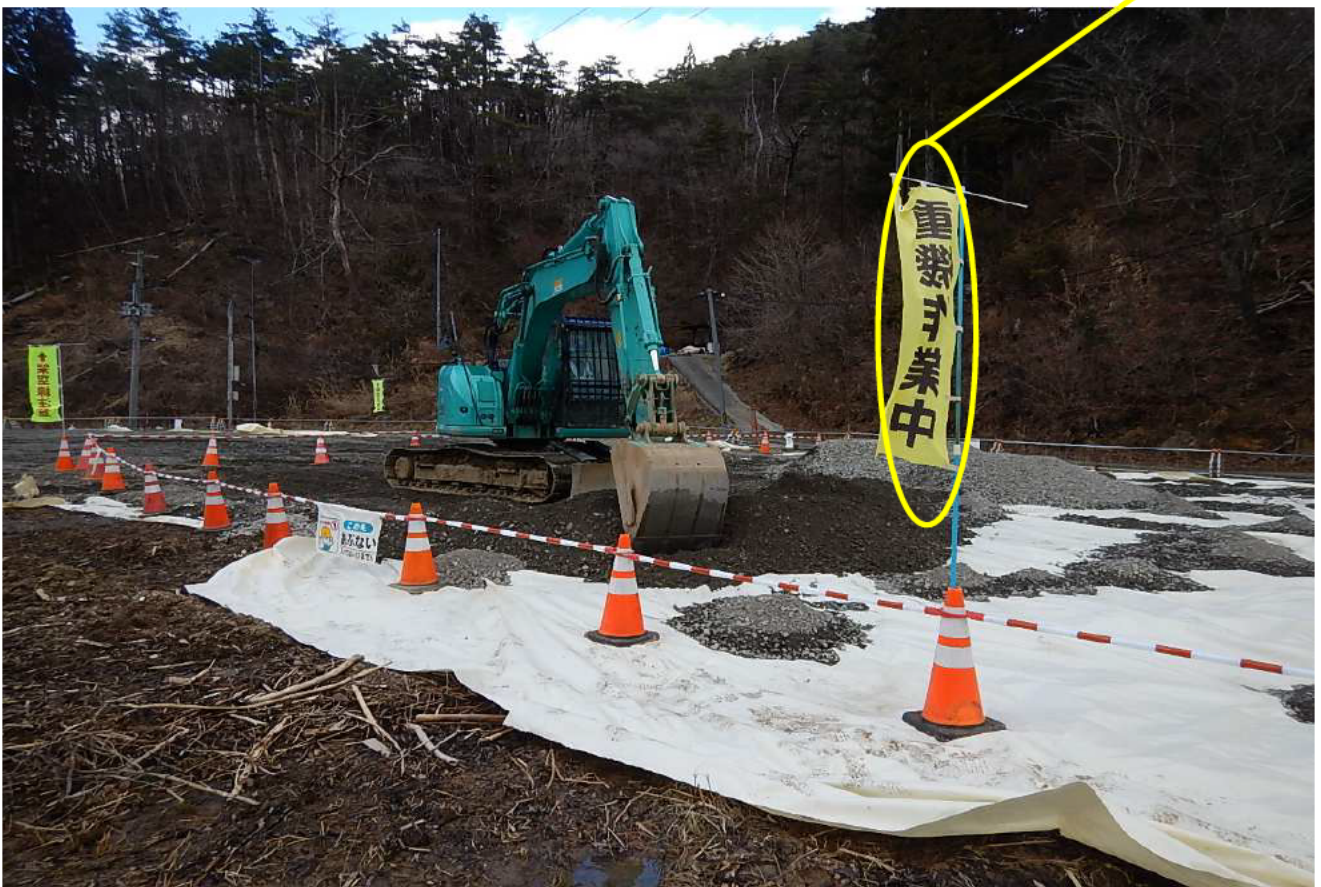
重機作業中明示の旗
