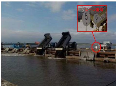
写真-1 浮棧橋直接投入状況
