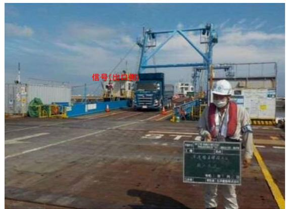
写真-3 乗入棧橋入口側信号、停止線、注意喚起看板設置状
