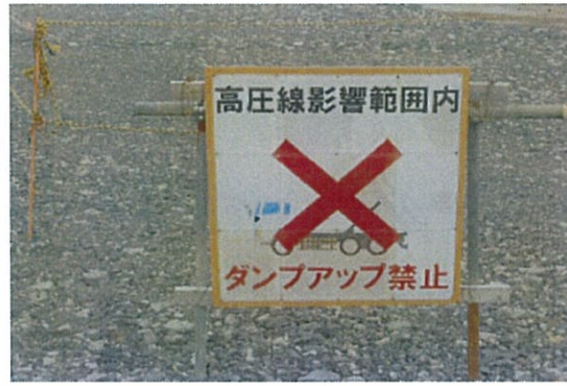
高圧線下の地盤高が変わらない場合のラフタークレーン・ユニック車の使用禁止とダンプアップ禁止看板
