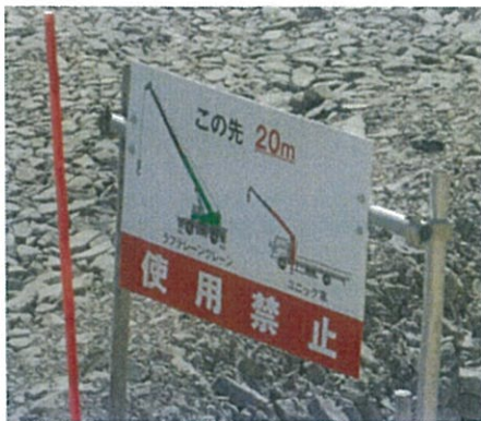
高圧線下の地盤高が変わらない場合のラフタークレーン・ユニック車の使用禁止とダンプアップ禁止看板
