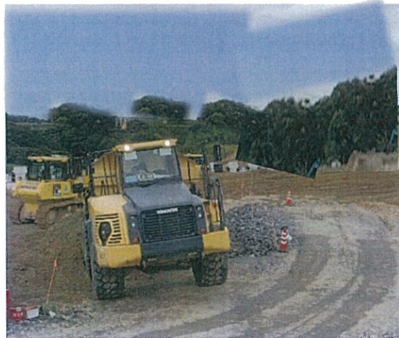
重ダンプと特大車両系建設機械の施工状況
