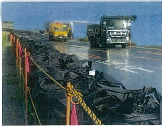
大型土納袋と鉄ピン+トラロープを使用した安全通路区画表示（安全通路側より）
