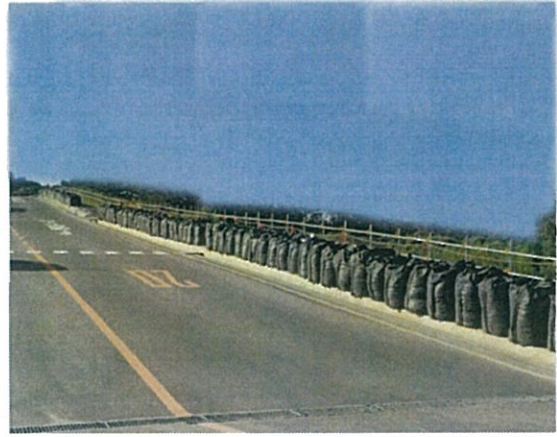
大型土納袋と鉄ピン+トラロープを使用した安全通路区画表示（車道側より）
