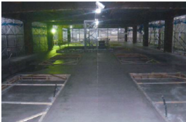
型枠の止め枠を床組に利用例
