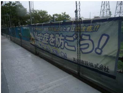
吊足場の作業員が必ず通る通路に注意喚起横断幕 (風荷重を足場構造計算に合わせる為メッシュタイプを使用)
