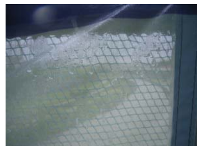
吊足場の作業員が必ず通る通路に注意喚起横断幕 (風荷重を足場構造計算に合わせる為メッシュタイプを使用)
