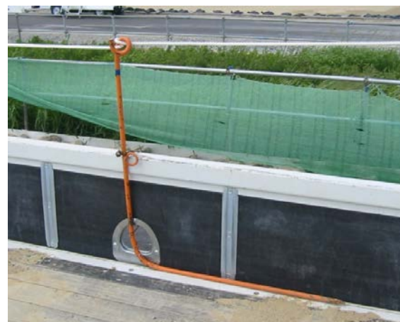
②端部ロープ・支柱固定状況（内側）
