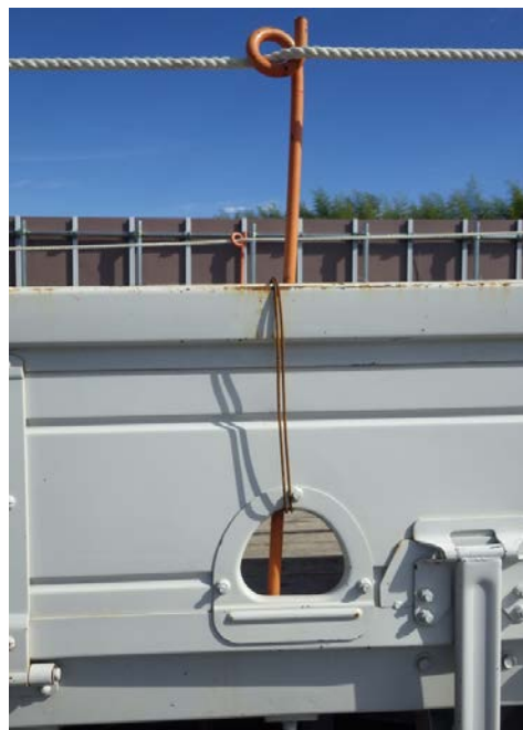
①端部ロープ・支柱固定状況（外側）
