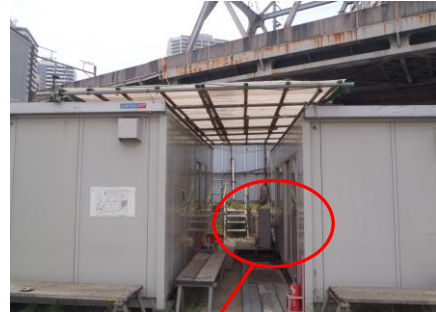
④休憩場所の日差し防止用屋根
