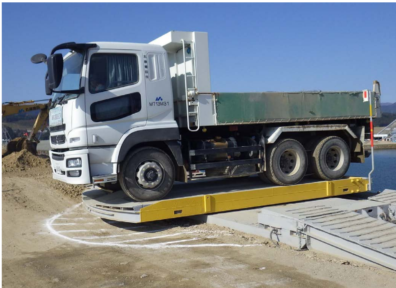
写真-2 ターンテーブル回転盤、回転範囲の明示
