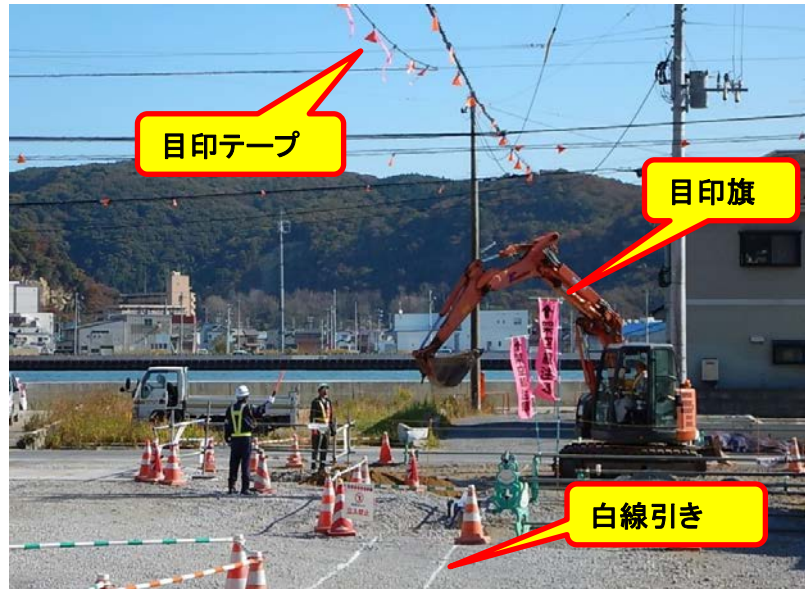
☆架空線近接部すべてに注意喚起の目印を取付☆
