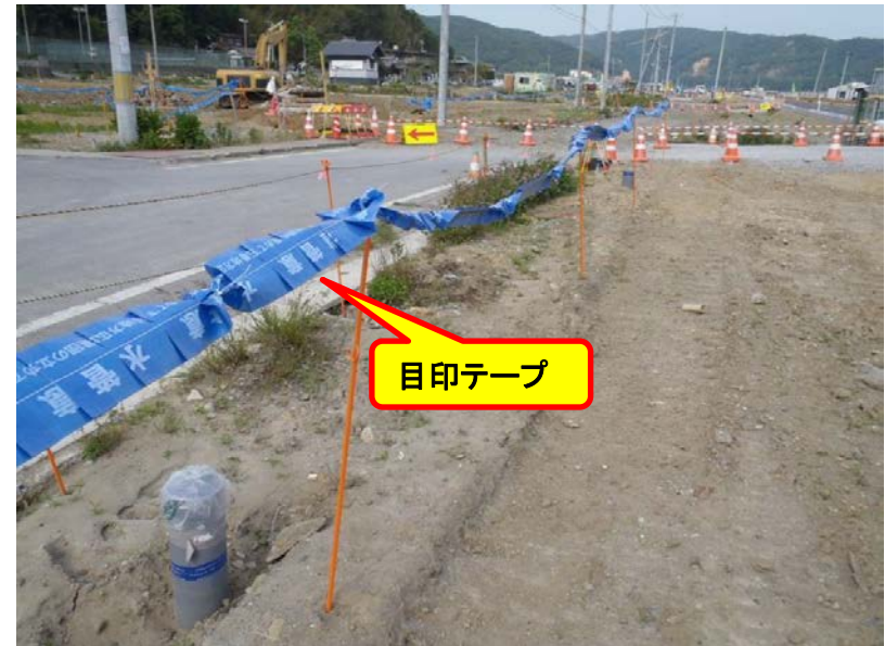
☆地中埋設仮設水道管地上部に目印テープを設置☆
