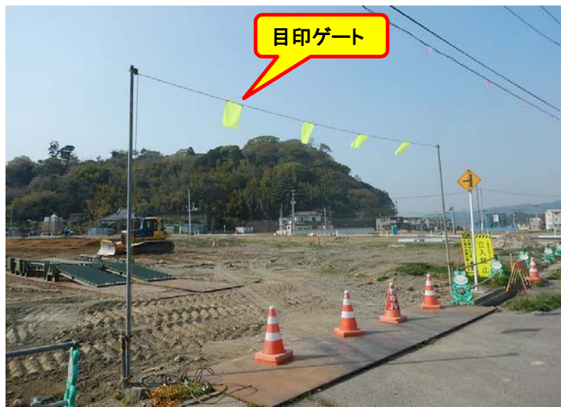
☆架空線下部に門型ゲート設置☆
