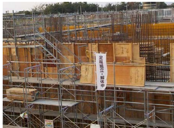
白:足場組立解体中
