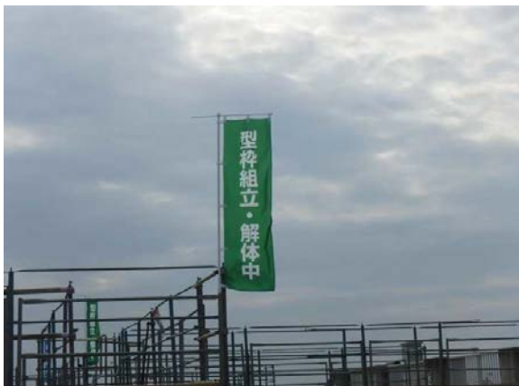
緑:型枠組立・解体中
