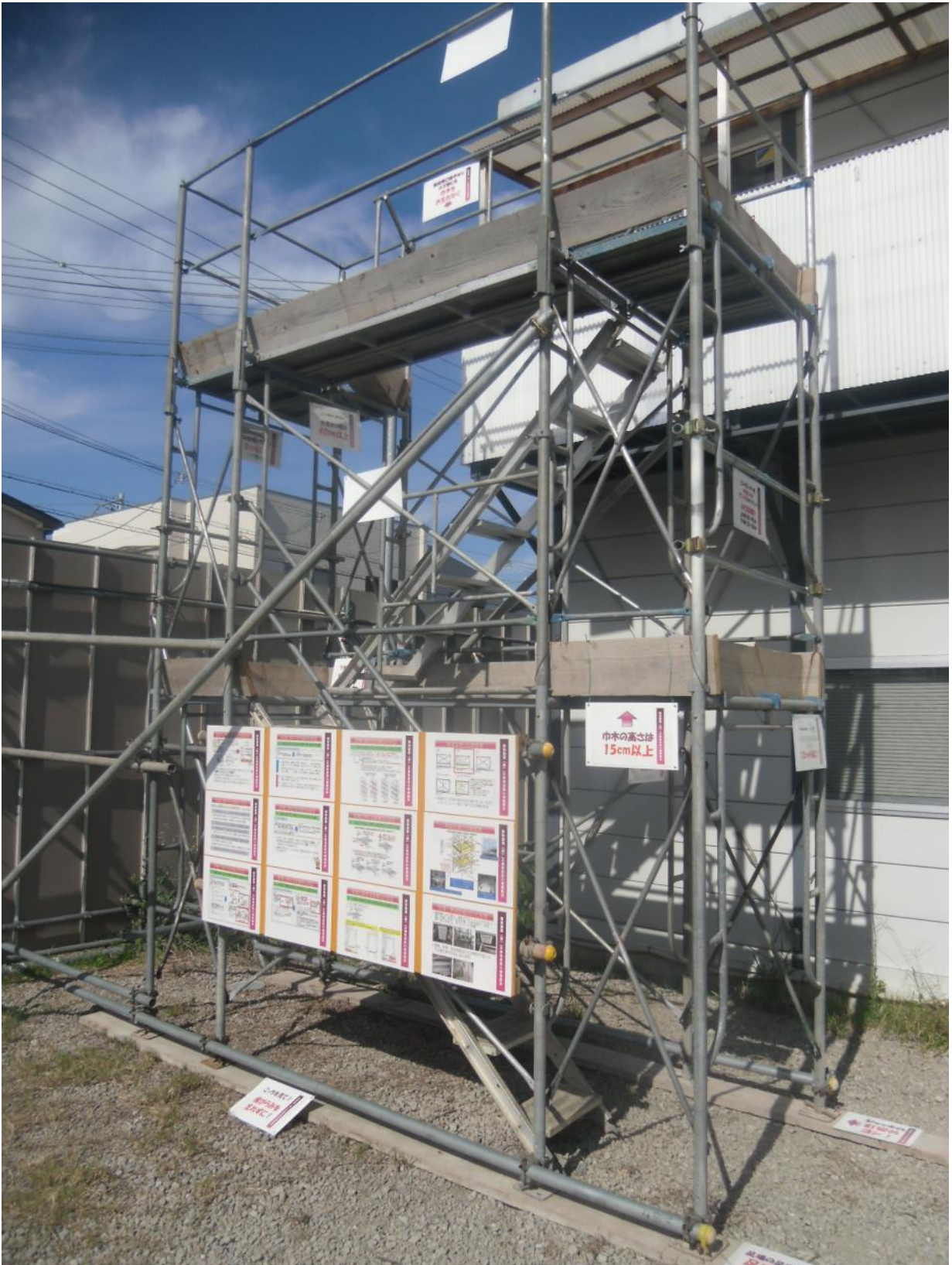
朝礼広場に実物の足場を組み立て、教育訓練に使用
