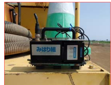
重機後方に設置 (タイヤローラー・ブルドーザー)
