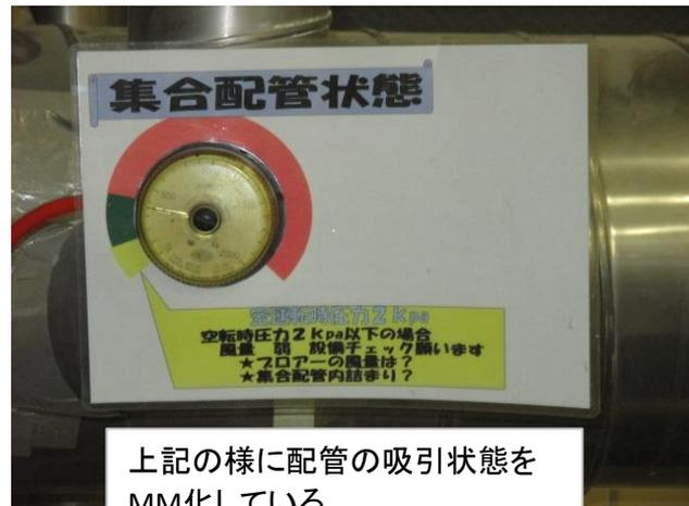
上記の様に配管の吸引状態をMM化している。
