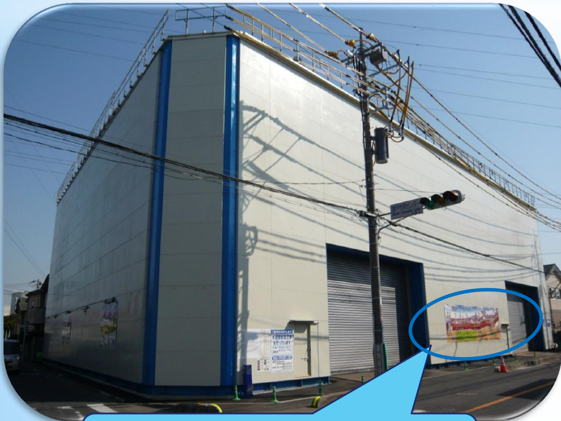
工事概要をハウスの外に明示！
