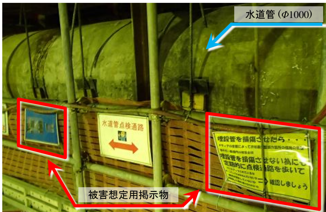
図-2 埋設物損傷時の被害想定および点検時における注意事項
