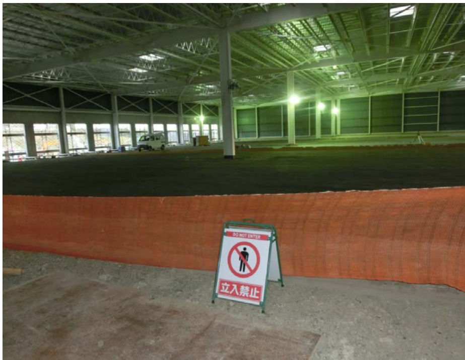
安全の見える化：立入禁止区画の明示(オレンジネット大成ロテック)
