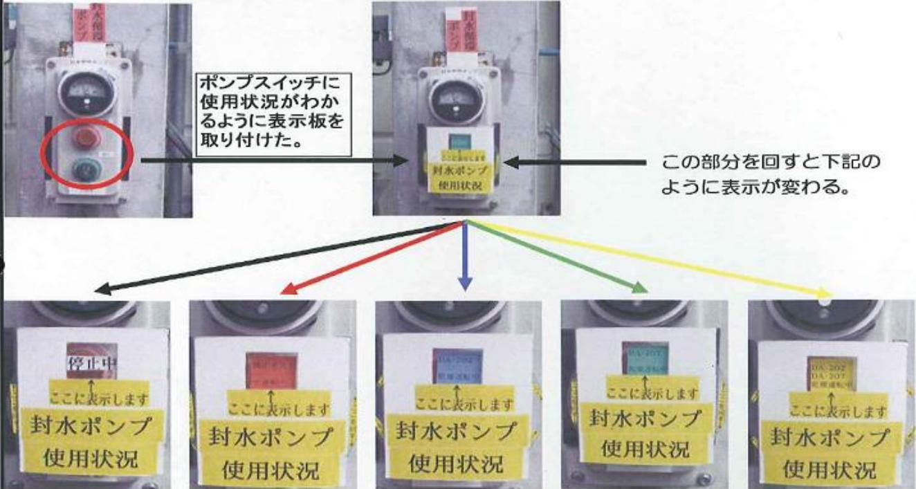
**停止中** **減圧テスト中** **DA-202乾燥中** **DA-207乾燥中** **DA-202・DA-207乾燥運転中**
