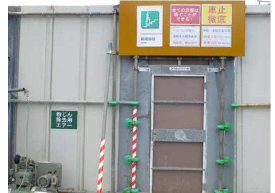
③現場ルールの周知
