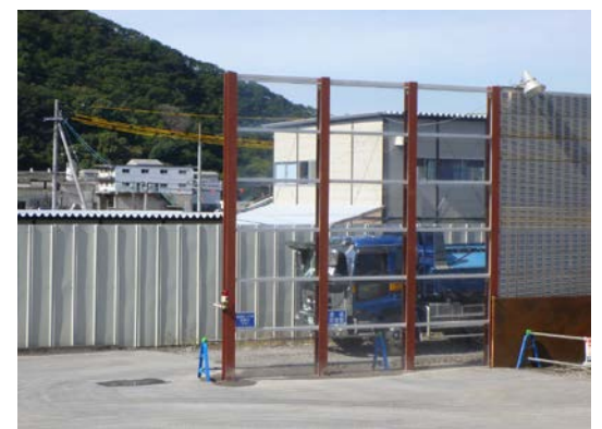
⑥隣接工区のダンプ見える化(透明防音壁)
