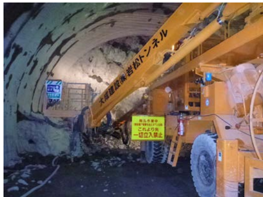
⑤削孔中、切羽立入禁止表示
