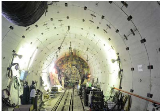
集煙機稼動時の坑内状況(非常にクリアな視界確保)
