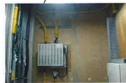
携帯ケーブル: 養生+注意表示
