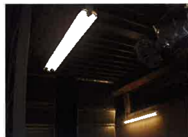
空調機械室・EPS 電灯活線
