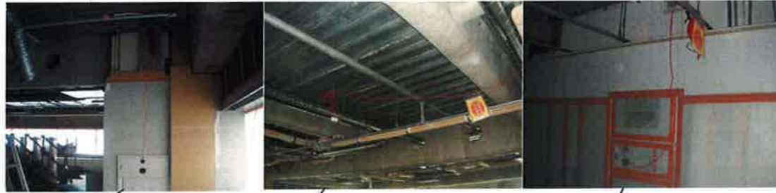
感知器仮設ケーブル: 注意表示
