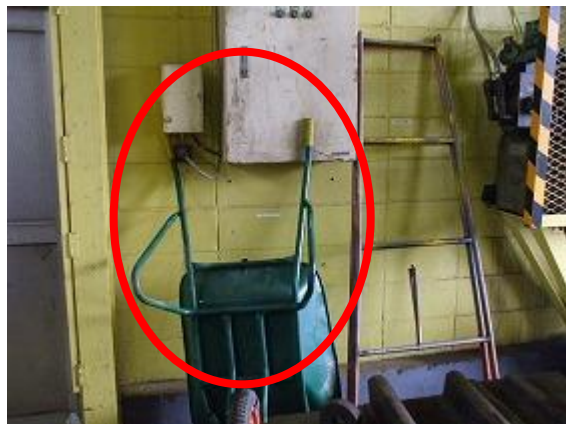
一輪車の置き方が不安定(工場)
