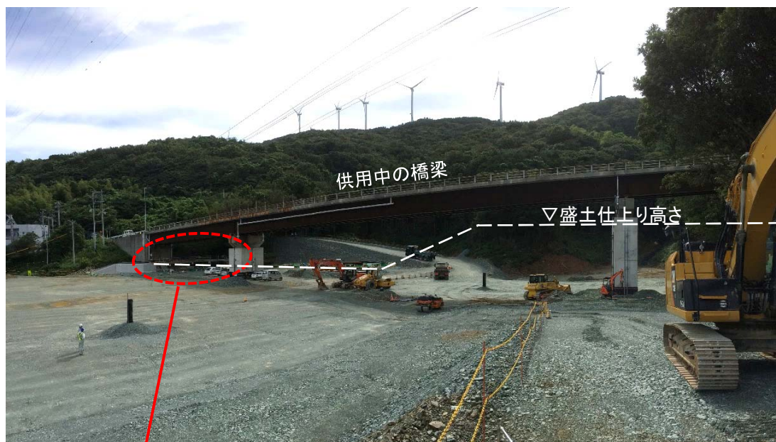
橋桁下部作業場所全景
