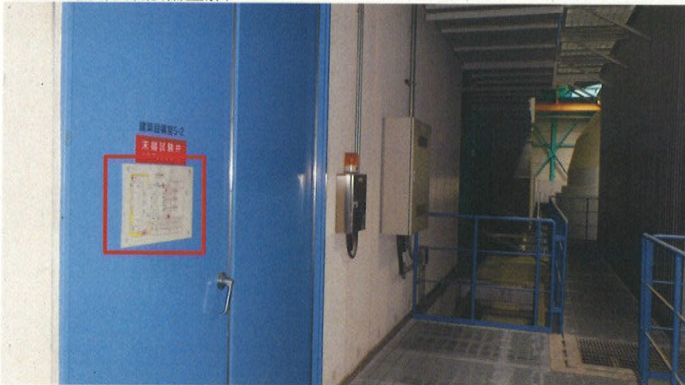
○5階西側(建築設備室扉)
