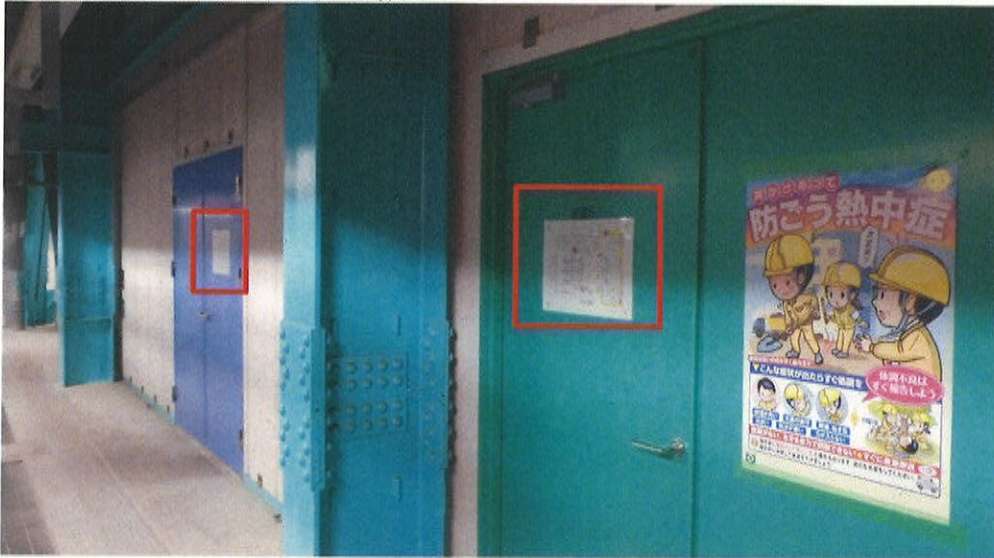
○5階東側(建築設備室・前室扉)
