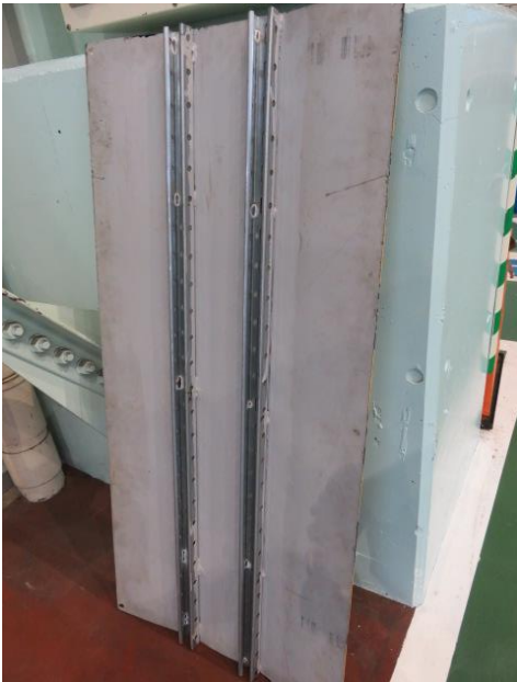
ウ. 電線ケーブルカバー(裏側) (カバー裏に部材を取り付けケーブルを保護できる)
