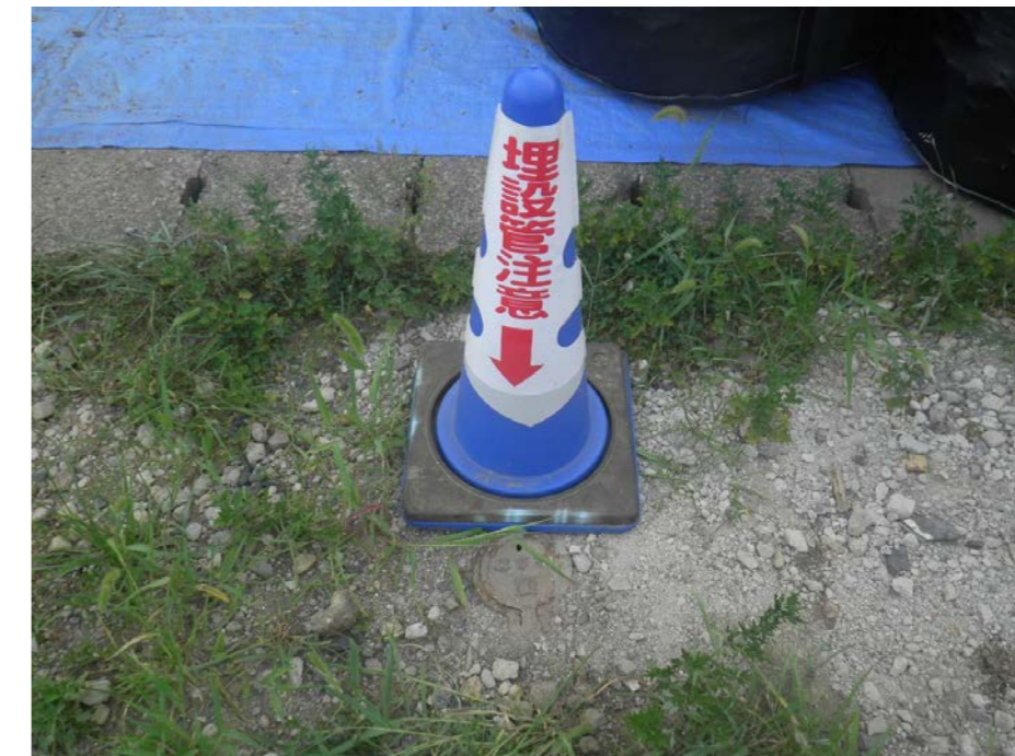
埋設管注意喚起
