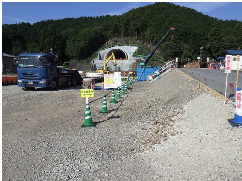
オリジナル注意喚起【作業員通路・路肩注意】
