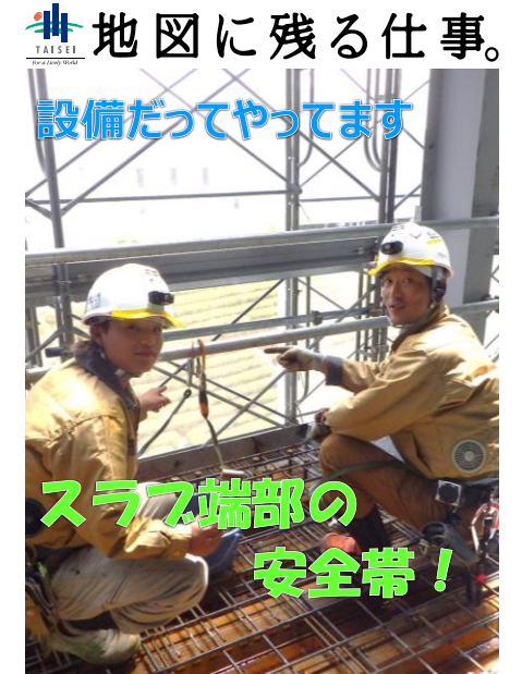
リンナイ株式会社 晚工場 組立棟他新築工事作業所 職長会
