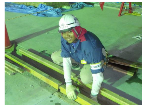
ベトナム人（型枠工）
