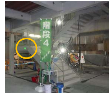
④ 階段4：1階 近景
