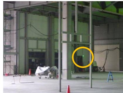
② 階段3：1階 バトランプ
