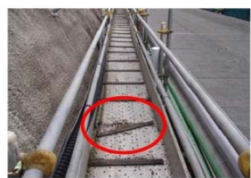
× 滑り止め桟木が外れているので直す事
