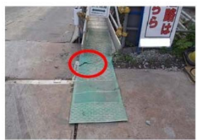
× 安全通路マットが破けているので交換の事
