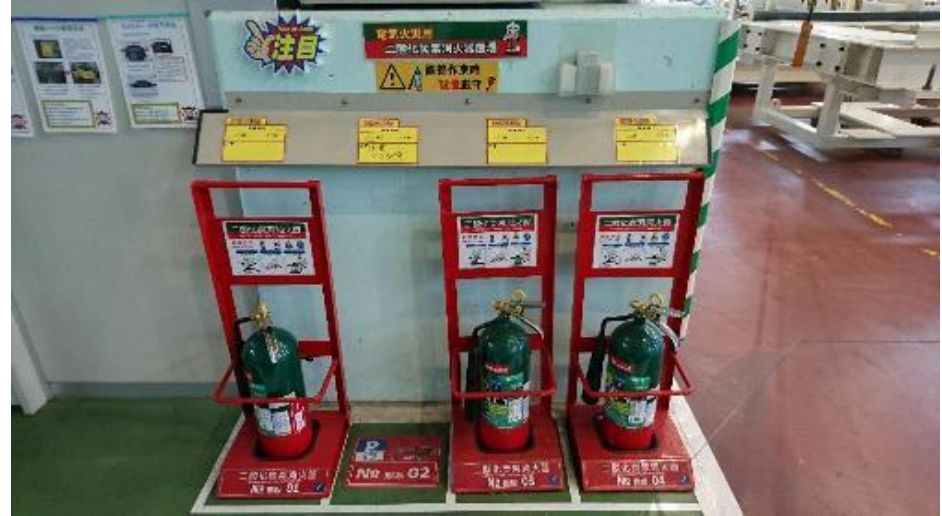
②NO. 2消火器を作業場所へ移動した後
