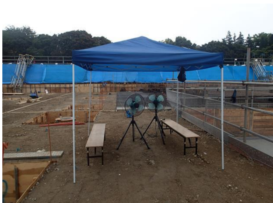
現場内のテントによる休憩所の設置
