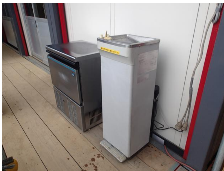
冷水器・製氷機の設置
