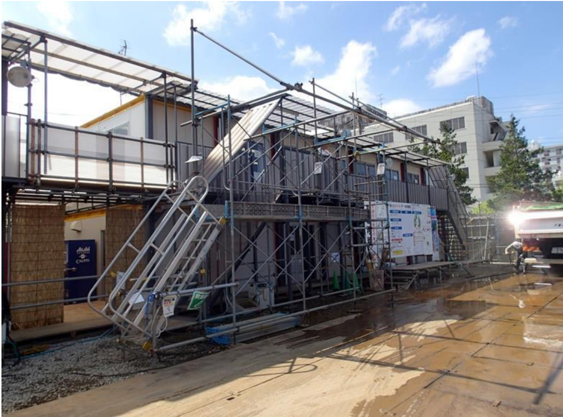
ダンプ荷台への飛散防止シート作業用安全施設
