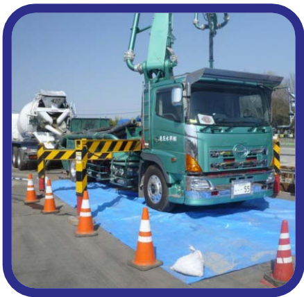
ポンプ車下面養生
