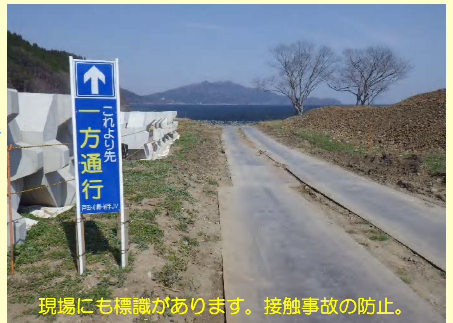
現場に入ったら必ず作業の手順等を確認・周知。
