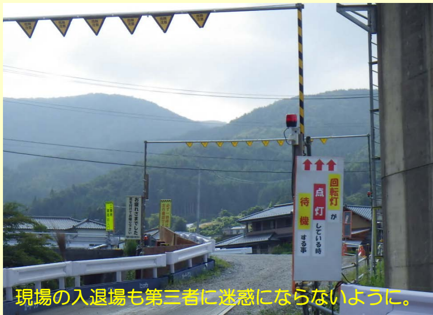
入場してすぐは慣れないため、現場の基本から。
