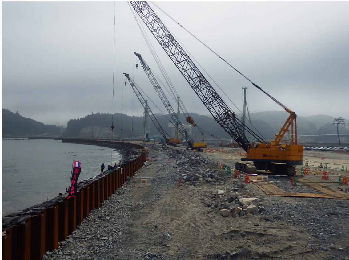
写真-1 被覆石据付け作業状況
