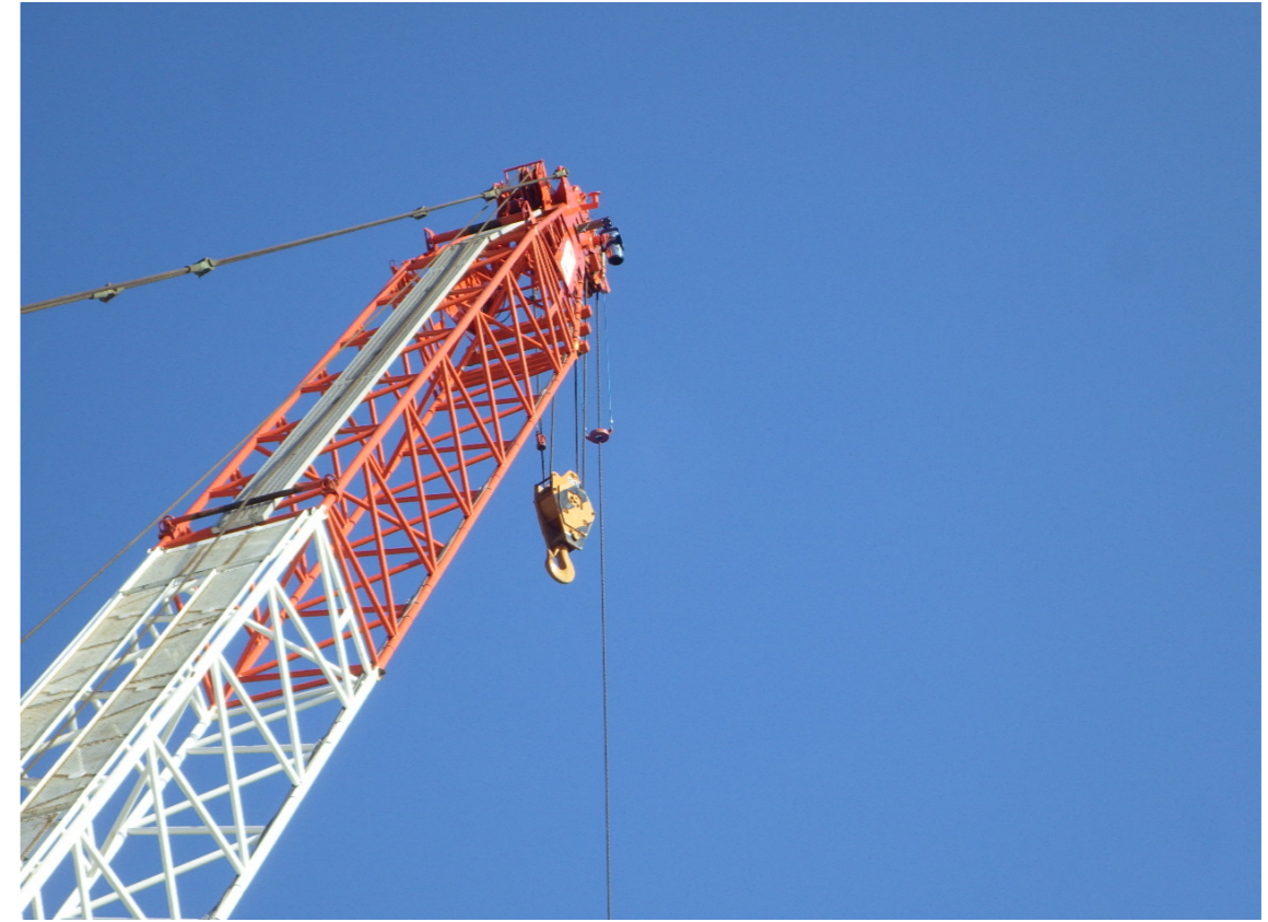
写真-3 クレーンカメラ設置状況
